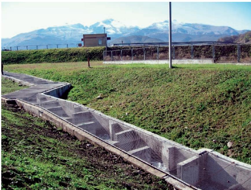
**Рис. 5.44.** Лестничный рыбоход Аушигерского гидроузла на р. Черек. Общий вид (фотография Г.Г. Филиппова)
