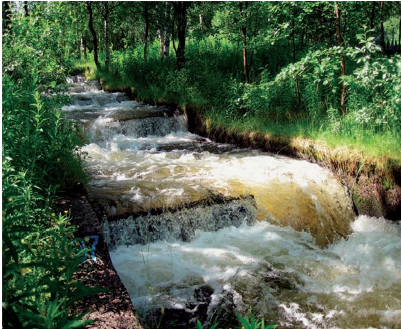
**Рис. 5.38.** Фрагмент лестничного рыбохода Нижне-Тулومского гидроузла (фотография Г.Г. Филиппова)
