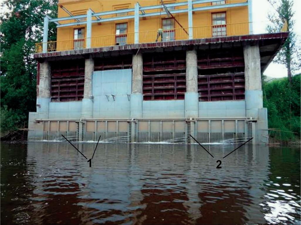
**Рис. 7.23.** Жалюзийное рыбозащитное устройство водозабора Дорогобужской ГРЭС
