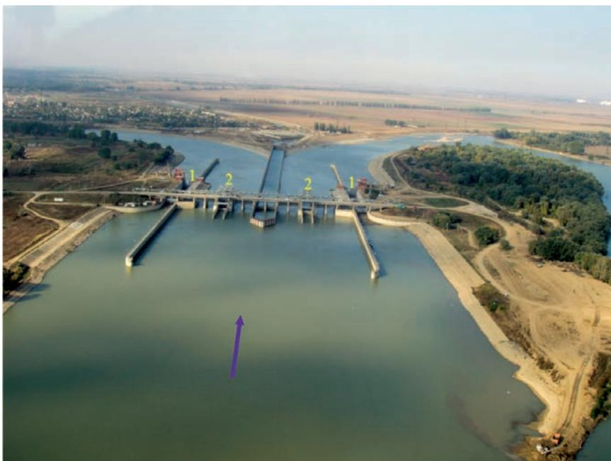
**Рис. 5.15.** Тиховский гидроузел с рыбопропускными сооружениями
