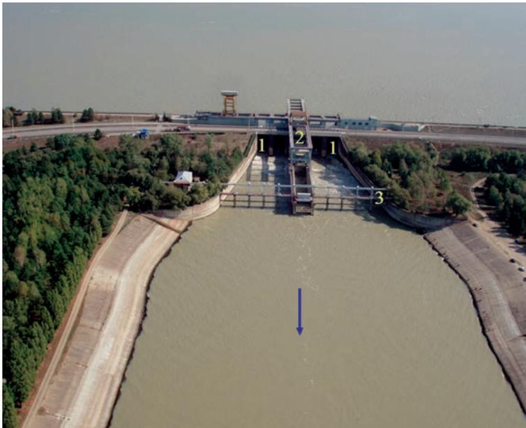
**Рис. 5.23.** Краснодарский гидроузел с механическим рыбоподъемником
